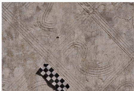
Dettaglio di intonaco sgraffito sul prospetto dell'edificio porticato.
