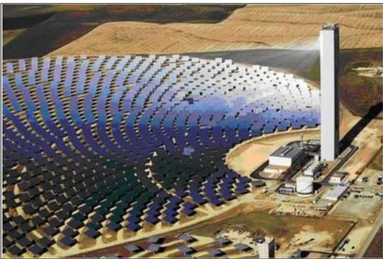
Centrale solare a concentrazione a torre PS10, Siviglia (Spagna)
