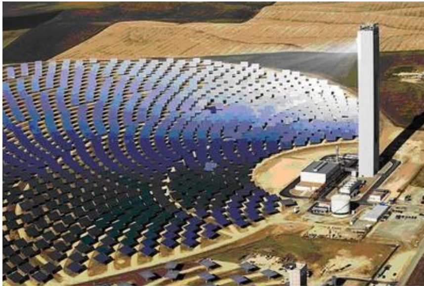
Figura 2: Impianto solare PS10 (Siviglia, Spagna) con campo a nord della torre [P.2]
