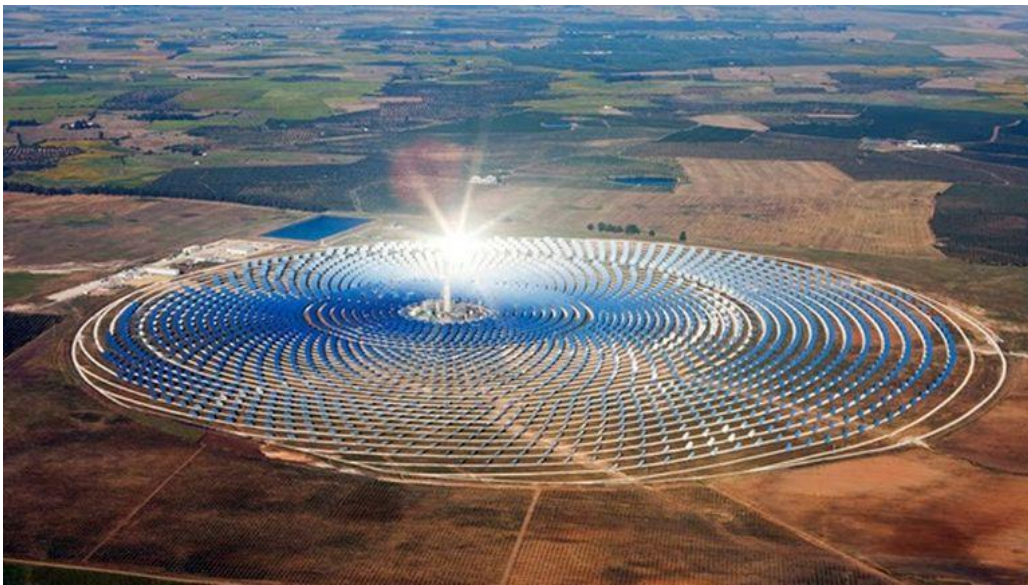
Figura 1: Impianto solare Noor 3 (Quarzazate, Marocco) con campo a 360° intorno alla torre [P. 1]
