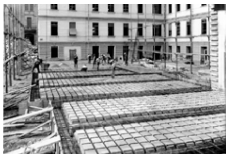
Il cantiere durante l'ampliamento nel 1931-32, fondo Ufficio Tecnico, ACLo.
