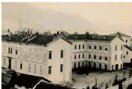
Costruzione delle Scuole Comunali nel 1894, fondo Ufficio Tecnico, ACLo.
